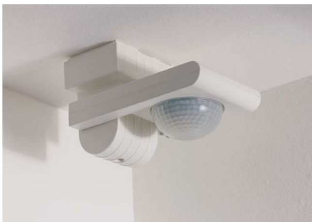
Детектор смонтирован на потолок
